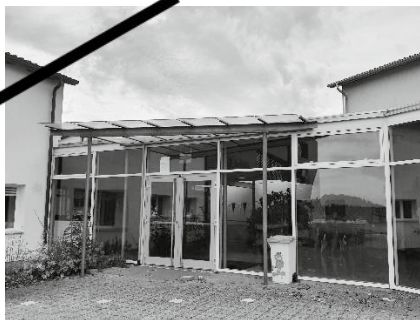
Im Foyer, Stollen 39 Schulanlage Rapperswil
